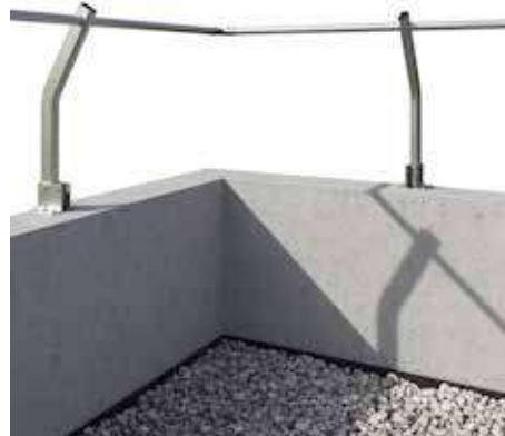
Ausführung 1 - mit Brüstung \geq 60 cm
