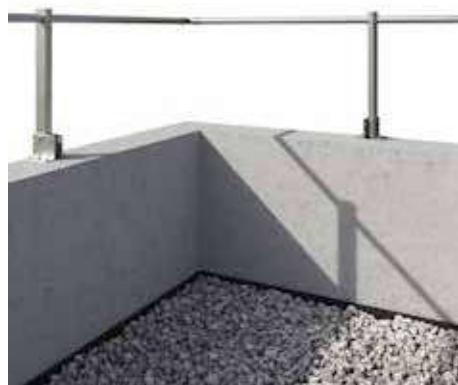
Ausführung 1 - mit Brüstung \geq 60 cm
